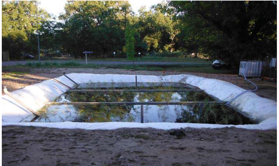
Biofiltre plante de roseaux
