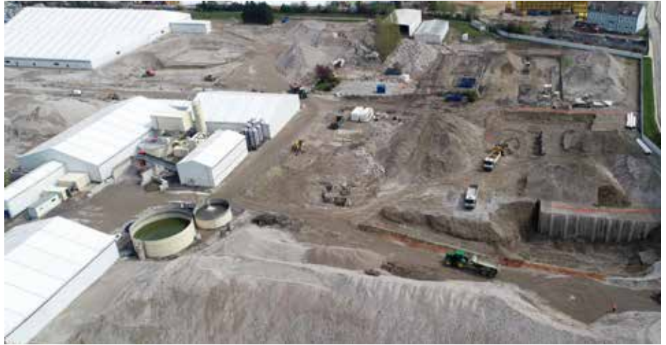
Figure 5 : Vue générale en cours de chantier : excavations hors et sous tente, confortement et unités de traitement
