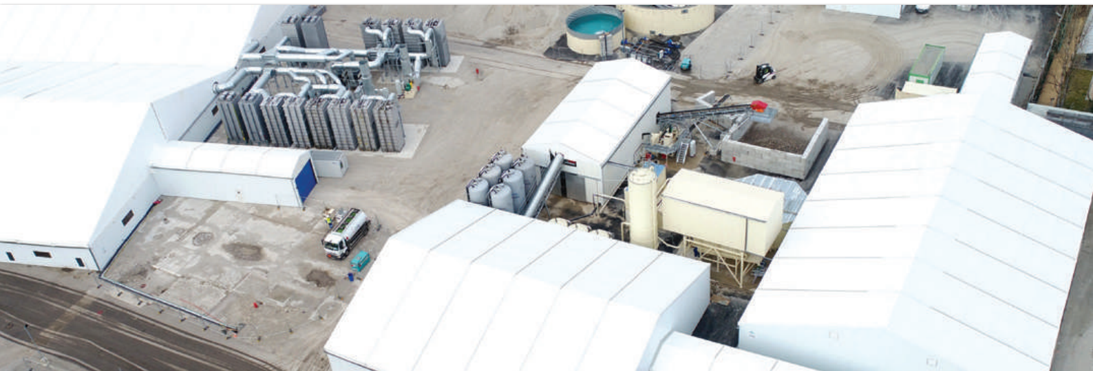
Installations de traitement de terres à grande échelle par lavage
