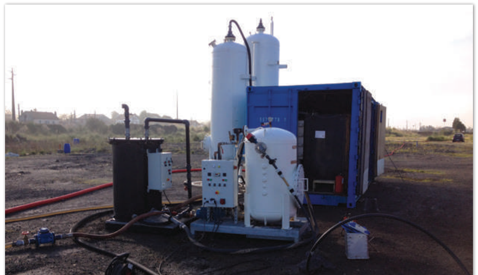
Essais pilotes de terrain de traitement des eaux souterraines par sparging/venting et extraction multiphase
