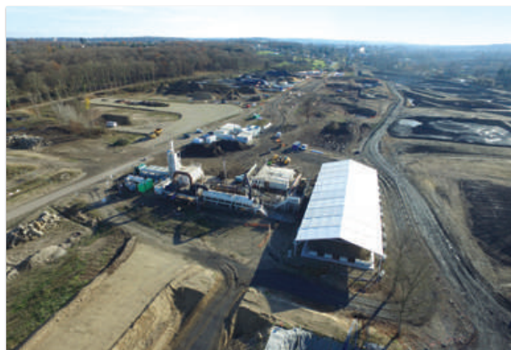
Vue générale du chantier depuis le Nord avec l'unité de désorption thermique au premier plan et la zone des travaux au second.
