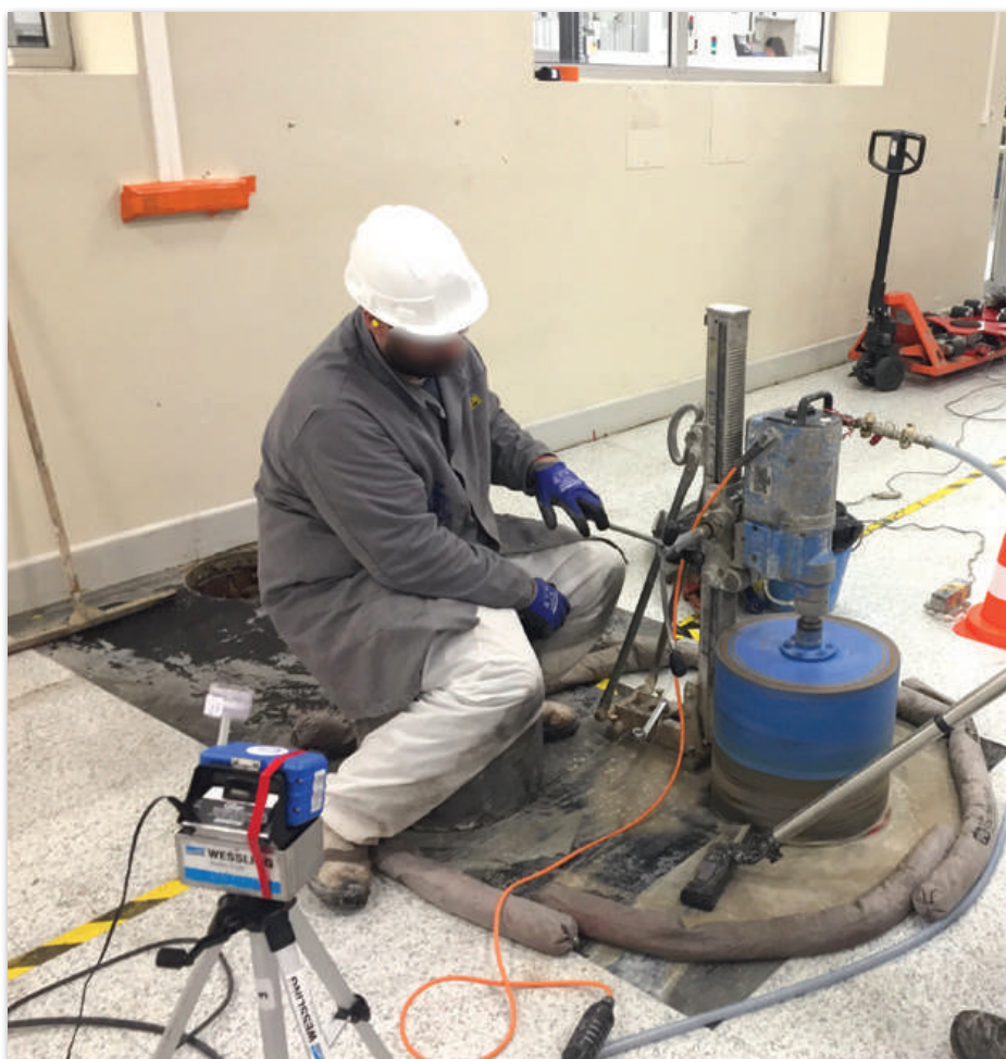
Opération intrusive avec suivi d'empoussièrement et vibrations
