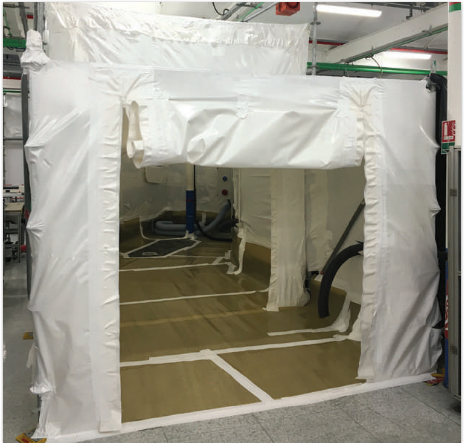
Vue d'une des trois zones de confinement
