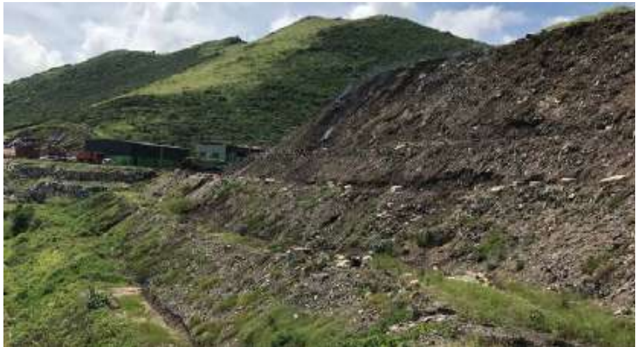
Fig. 4 : Signes d'instabilités géotechniques et feux couvant sur une décharge
