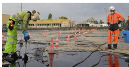
Figure 8: Barrière perméable réactive (Permeable Reactive Barrier - PRB) injectée (tube à manchettes)
