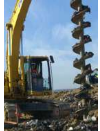
Fig. 8 : Création d'un bassin de stockage de lixiviats, et foration d'un puits biogaz
