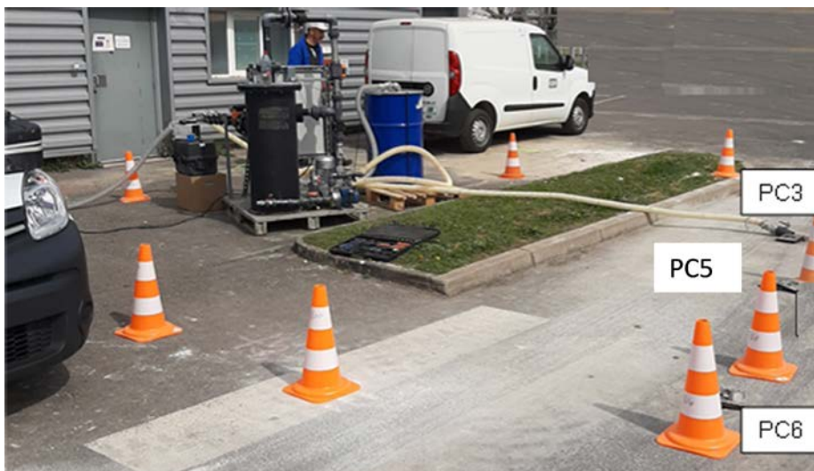
Fig 2 : Réalisation de l'essai pilote de terrain
