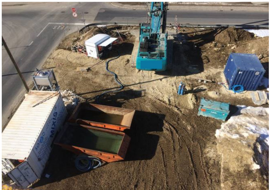
Essais pilotes terrain de réduction chimique par soil mixing avec injection de fer zéro valent et de biodégradation anaérobie
