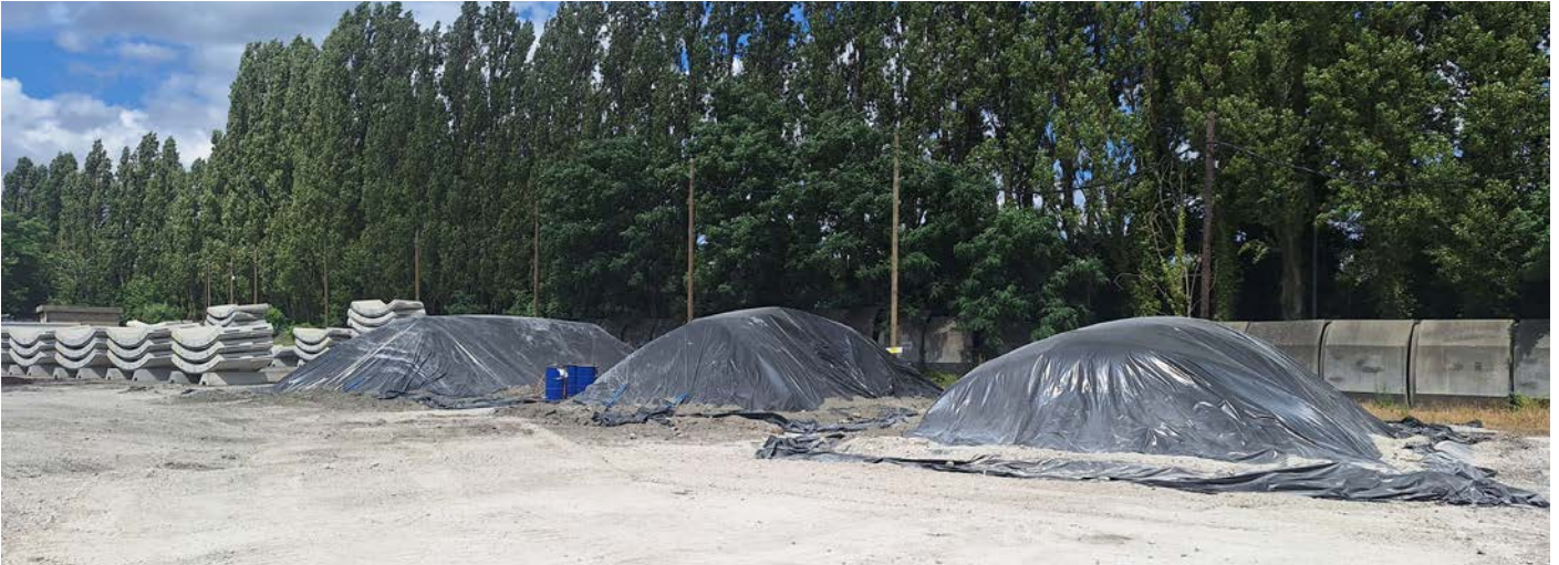
Figure 3 : Mise en place de 3 biotertres pilotes
