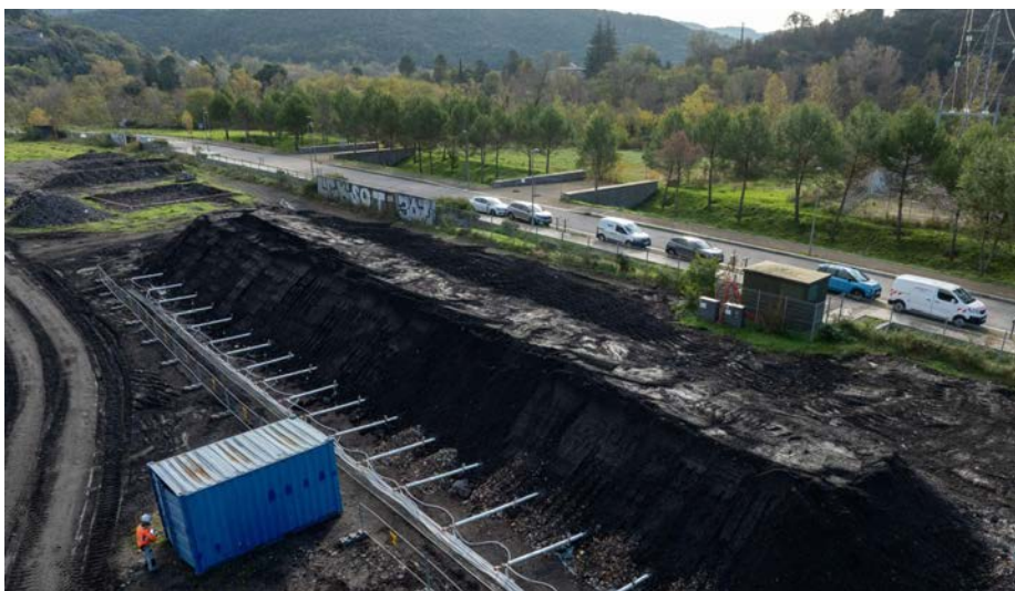
Illustration n°6 : Vue drone du chantier de traitement de la pollution - phase de traitement par thermopile DESOTHERM®
