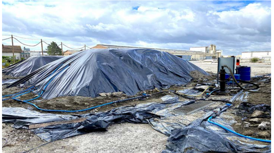
Figure 2 : Installation du biotertre
