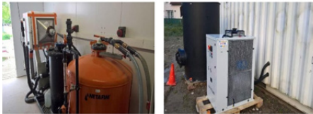
Essai pilote terrain de désorption thermique
