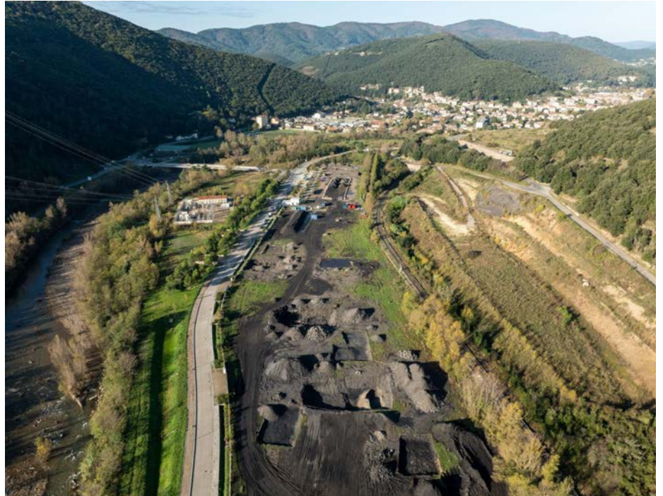
Illustration n°5 : Vue drone du chantier de traitement de la pollution - phase de gestion des PPC
