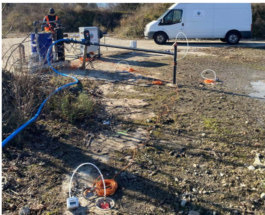
Essai pilote sur site de venting
