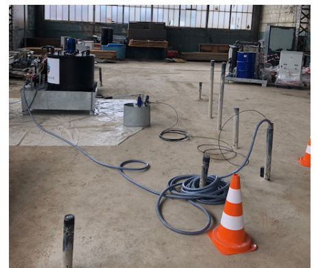
Essai pilote sur site d'injection d'oxydant
