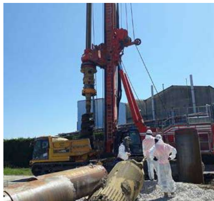
Figure 3a : Photos de la phase de forage (SBFS-Soletanche bachy) et introduction du réactif formulé par Sarpi Remediation
