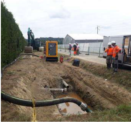
Figure 2 : Purge de la zone enherbée avec dévoiement des réseaux / Purge de la route
