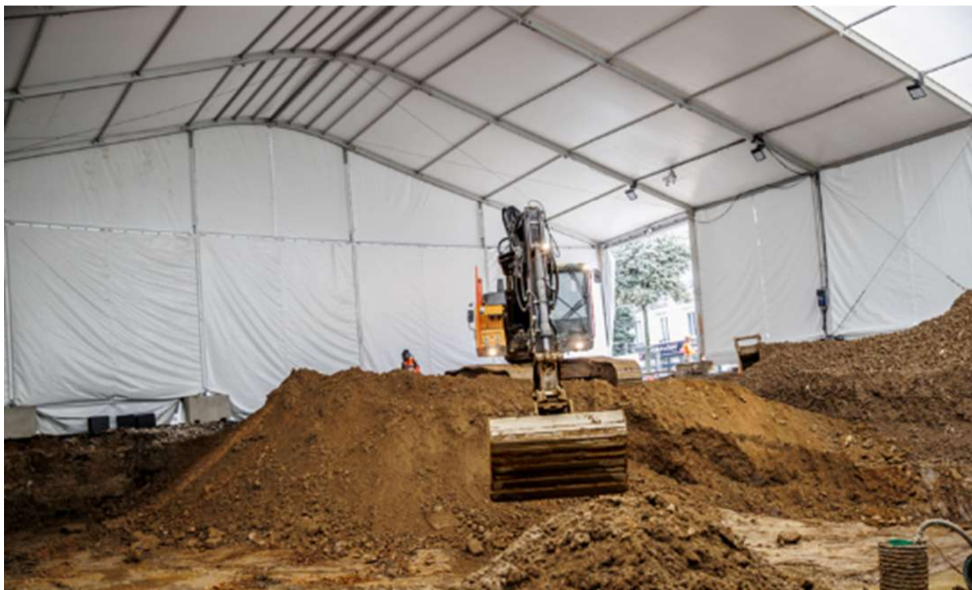
Figure 2 : Terrassement sous tente ventilée (COLAS Environnement)
