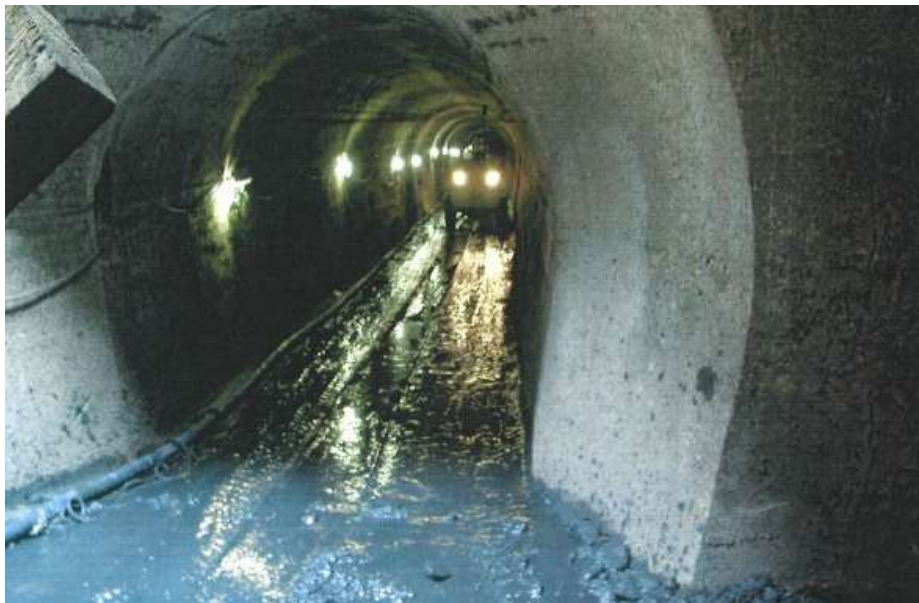
Photo 4 : Eclairage dans l'ouvrage et curage des sédiments
