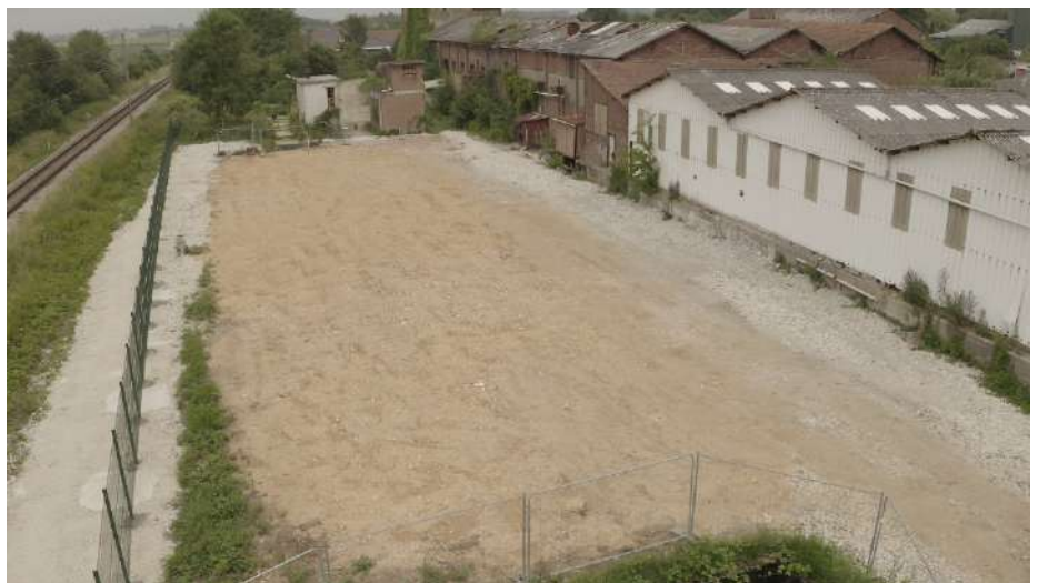
Illustration 6 : Vue du bac en terre après travaux (source : ADEME)
