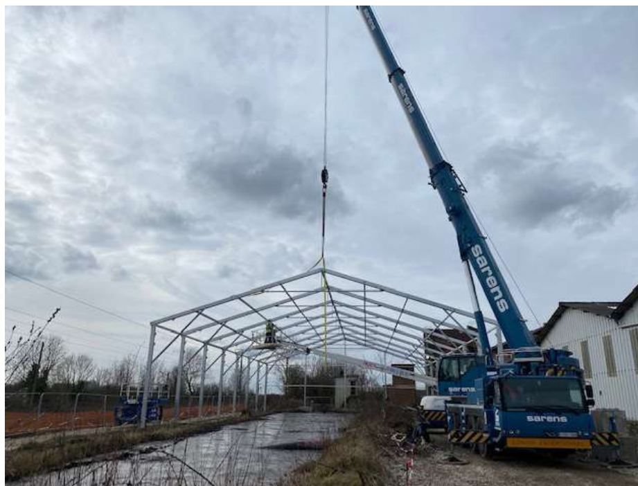
Illustration 4 : Montage de la structure de la tente (source : ORTEC SOLEO)
