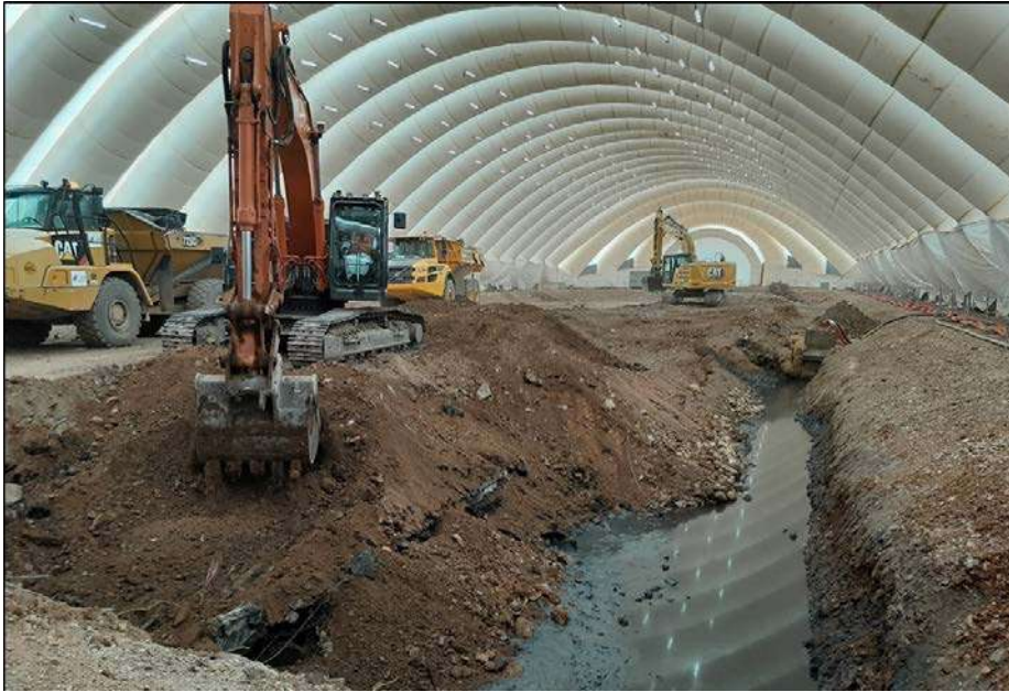
Photo 1 : Travaux d'excavation sous tente
