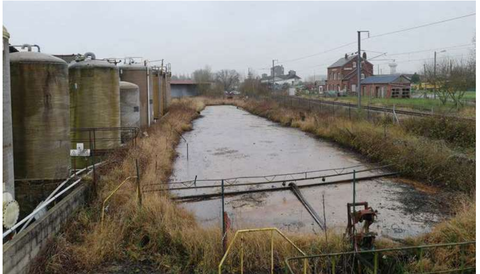
Illustration 2 : photographie du bac en terre avant travaux (source ADEME)
