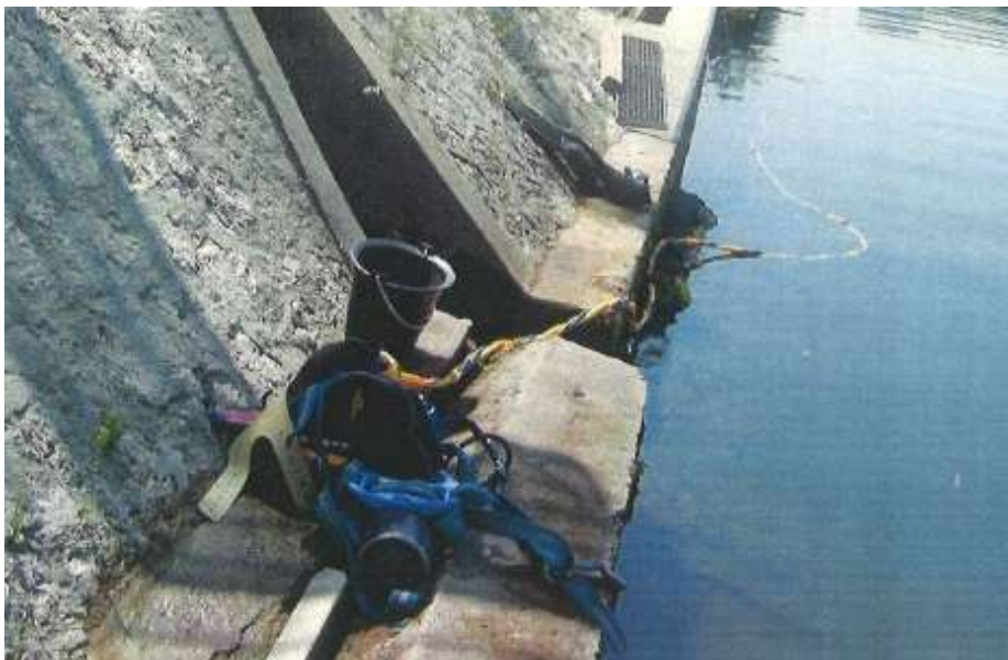
Photo 2 : Aperçu de la sortie de l'ouvrage à la Seine
