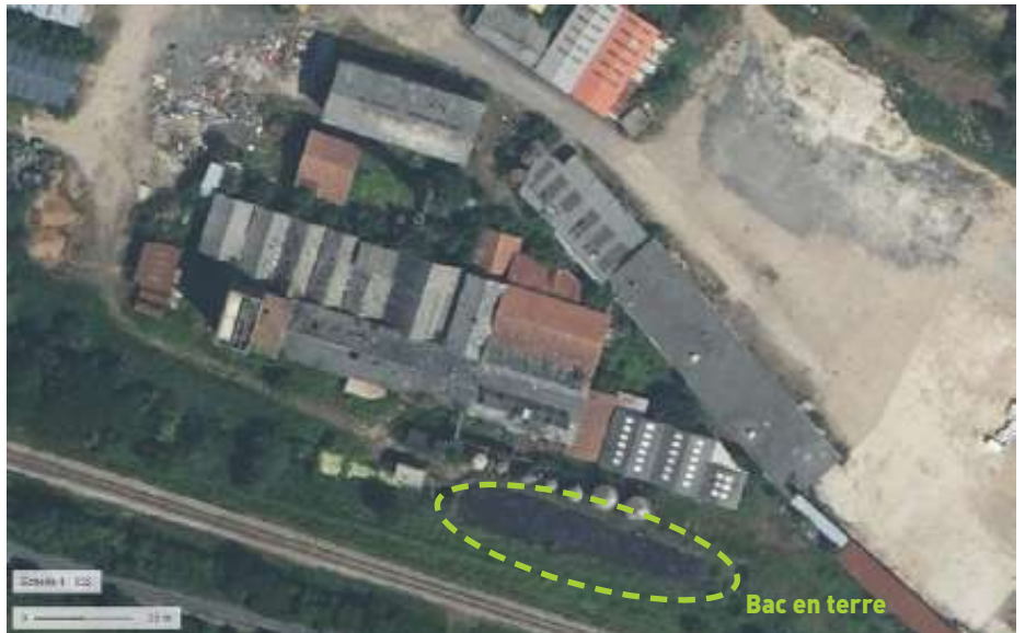
Illustration 1 : Situation du bac en terre avant travaux sur photographie aérienne (source : géoportail)
