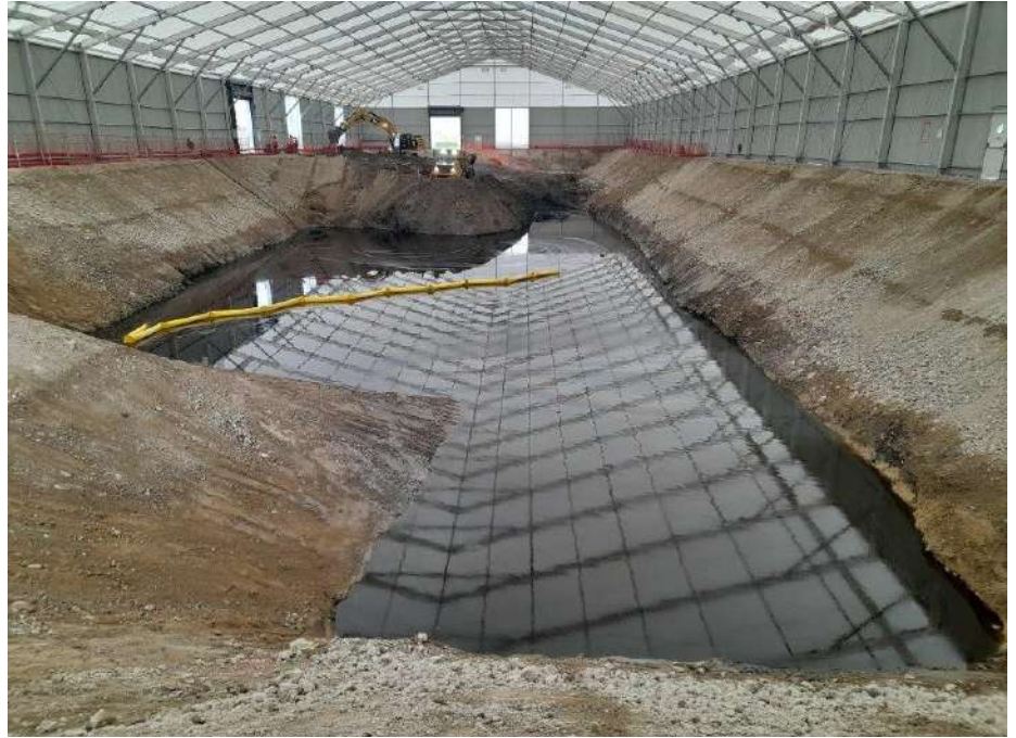
Figures 3 : Terrassements sous tente
