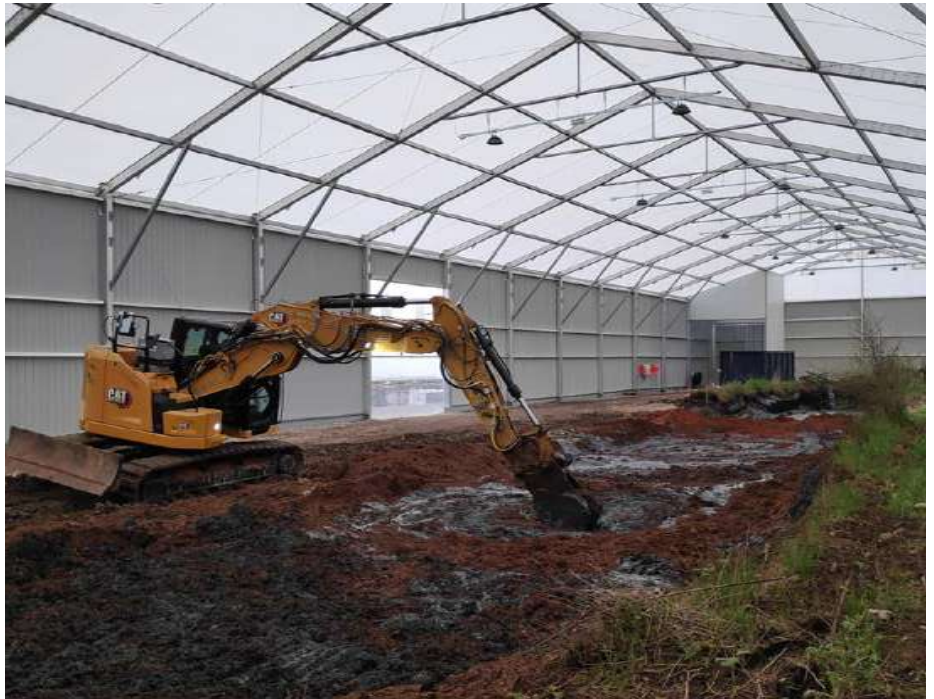
Illustration 5 : Structuration des boues à la sciure (source : ADEME)
