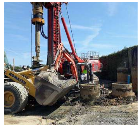
Figure 3a : Photos de la phase de forage (SBFS-Soletanche bachy) et introduction du réactif formulé par Sarpi Remediation
