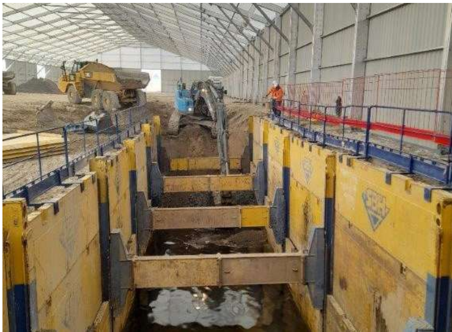
Figures 4 : Terrassements sous tente avec blindages
