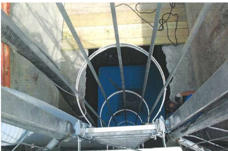
Photo 3 : Trémie d'accès à l'ouvrage
