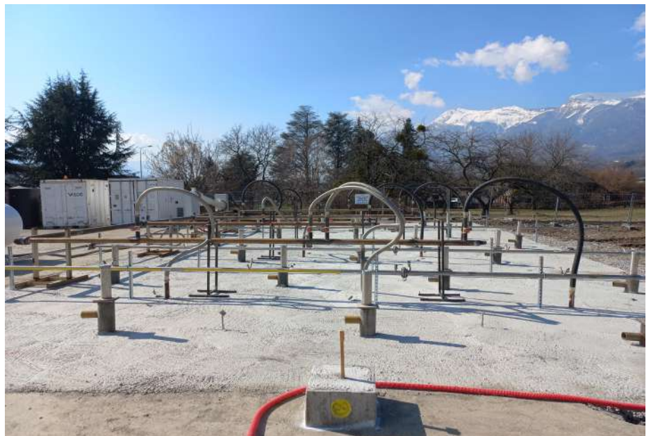
Figure 3 : limitation de l'impact par travaux in situ
