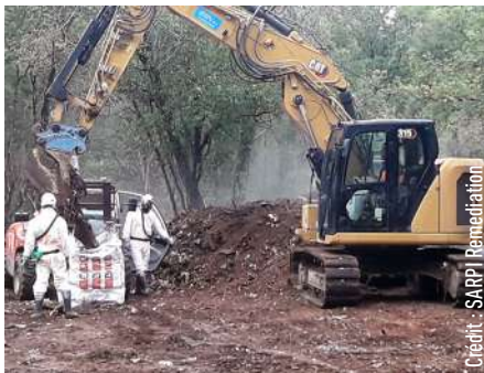
Excavation en conditions amiante
