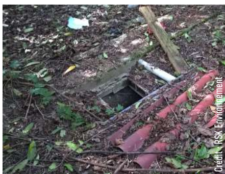
Exemple de plaque ondulée en cours d'enfouissement
