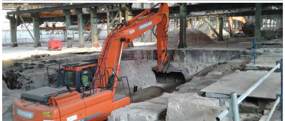
Figure 5 : Travaux de retrait des zones de pollution concentrée
