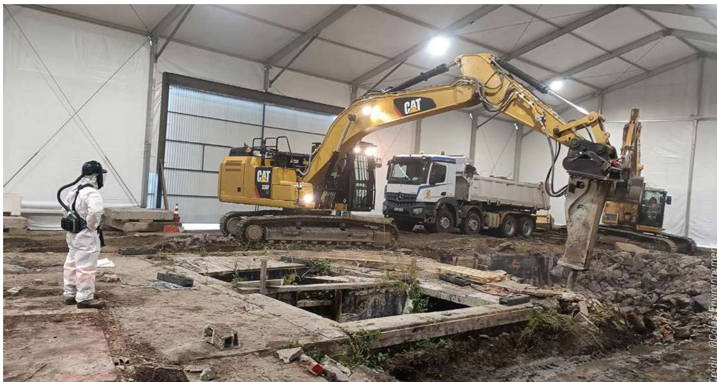
Travaux de dépollution sous tente
