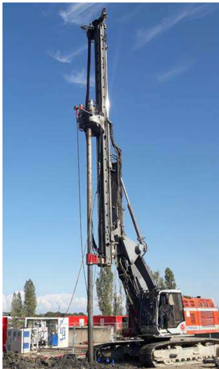
Figure 2 : Photographie de l'atelier de forage de soil mixing et de la centrale à coulis en arrière-plan.
