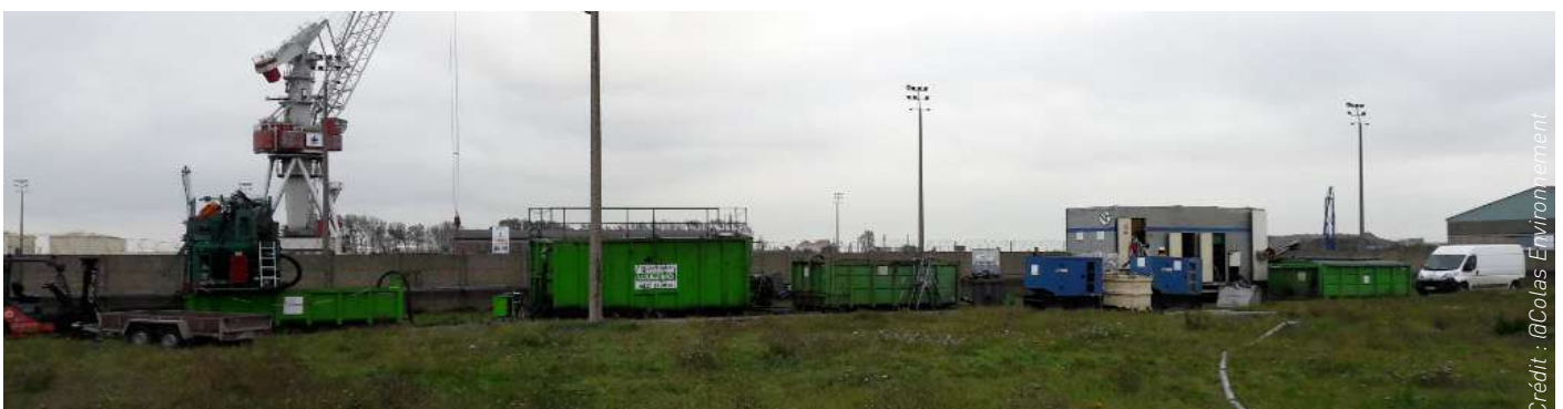
Zone de stockage des boues hydrocarburées curées
