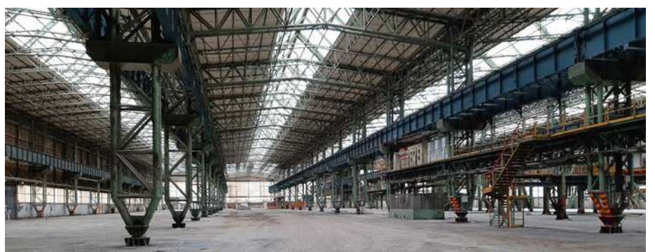
Figure 6 : Site prêt à accueillir de nouvelles installations
