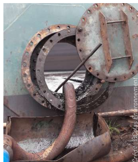
Curage d'une ancienne cuve de stockage d'hydrocarbures lourds
