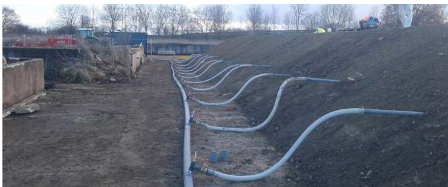
Figures 3 et 4 : Traitement des terres excavées
