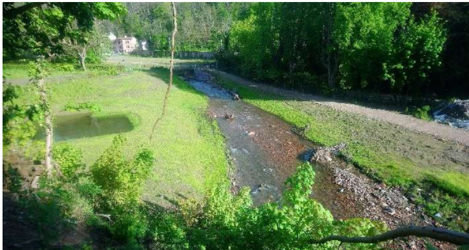
Vue des aménagements un an après travaux : zones humides, cheminement piéton et tronçon au droit des anciennes teintureries.
