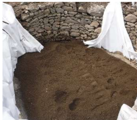
Remblaiement des puits avec les rhizomes de Renouée et les terrains inertes criblés.
