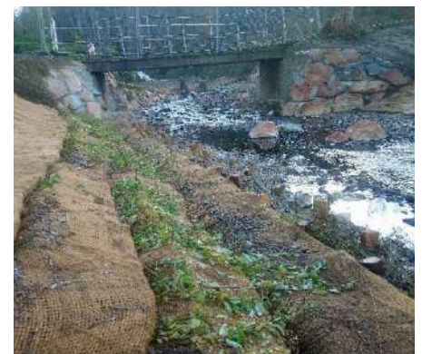
Protection de berges par des souches et fascines de saules.
