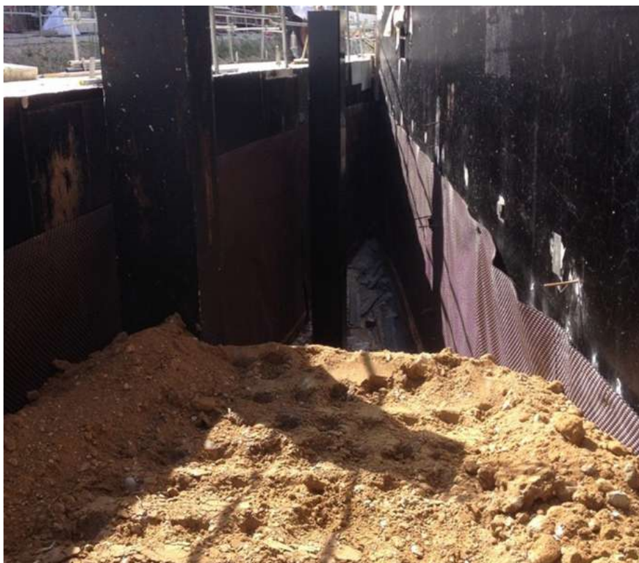
Remblaiement de matériaux contre voile
