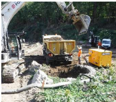
Remblaiement des puits avec les rhizomes de Renouée et les terrains inertes criblés.
