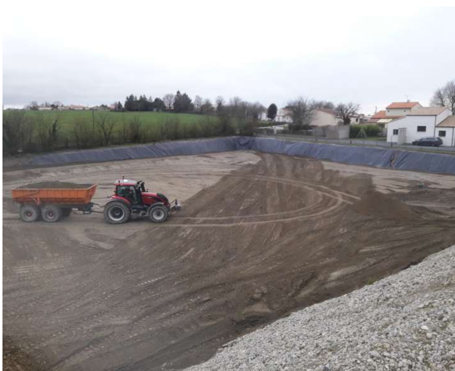
Réemploi de matériaux sous confinement étanche
