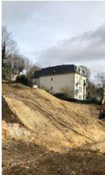
Exemple de déblais revalorisés non compatibles géotechniquement
