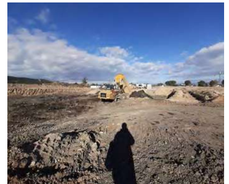
Figure 7 : suivi et tri en phase déblais / remblais
