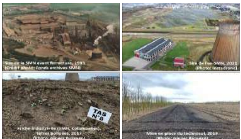
Figure 1 : Photos du site à Colombelles (14)
