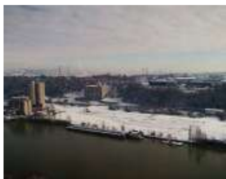
Le site Lafarge en 2019 ©Devisubox
