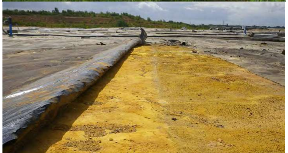
Figures 1 et 2 : vue d'ensemble du Grand Terril de Chrome PCUK à Wattrelos (en haut) ; Ouverture de la géomembrane et réalisation d'une tranchée dans les résidus chargés en Cr VI .
