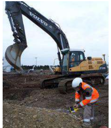
Terrassement de terres impactées aux COVs et gestion de cuves enterrées
