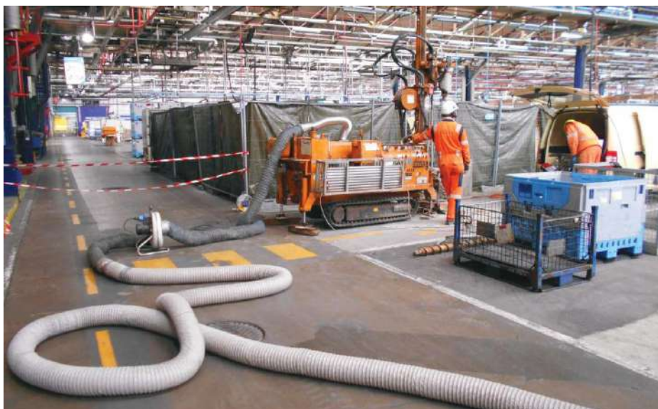
Figure 1 : Sondage MIP à l'intérieur d'un bâtiment.
