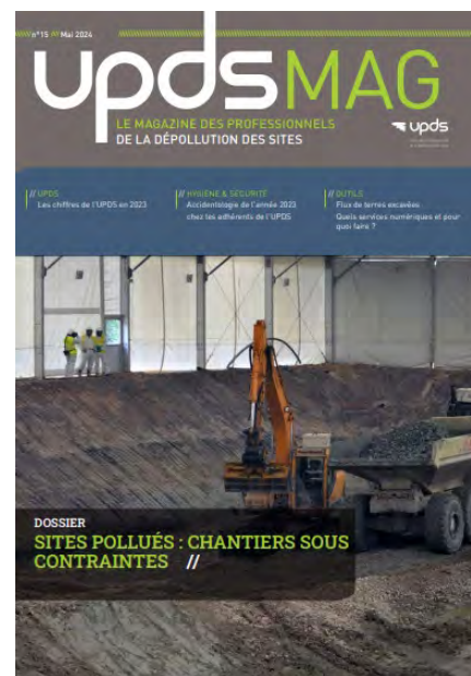
Mai 2024 Chantiers sous contraintes
