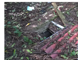
Exemple de plaque ondulée en cours d'enfouissement
