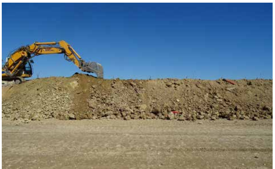
Opération de remblaiement par des matériaux de granulométrie variée, sans contrainte géotechnique majeure
