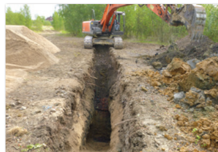
Mise en place du pilote de traitement. La pelle hydraulique excave les matériaux naturels limoneux qu'elle dépose sur la droite de la photo et les remplace à l'avancement par un mélange de sable et de FeO pulvérulents préalablement déposé en andains le long du pilote.
