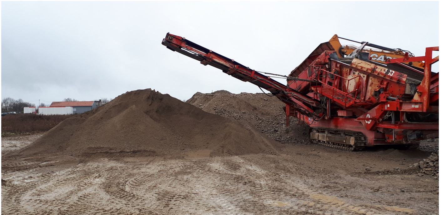
Pré-traitement des matériaux pour optimisation des volumes de déblais non inertes à gérer sur site
