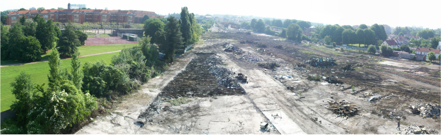
Tri des matériaux issus de la démolition et des terrassements pour valorisation, recyclage et réemploi
