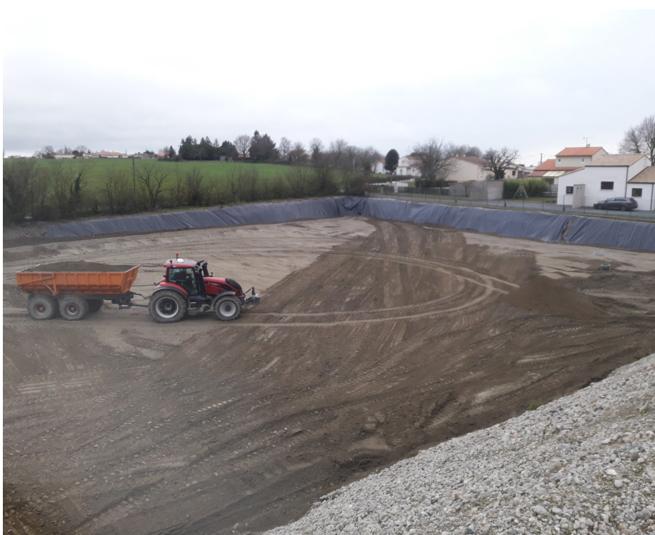
Réemploi de matériaux sous confinement étanche
