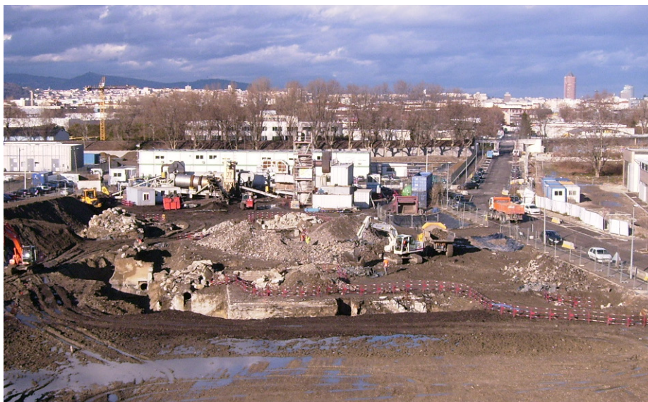
Traitement on site de matériaux pollués, avant leur réemploi sur site
