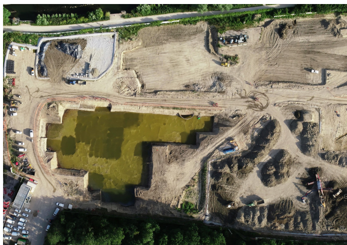
Vue aérienne du chantier, du maillage et des aires de stockage / traitement
