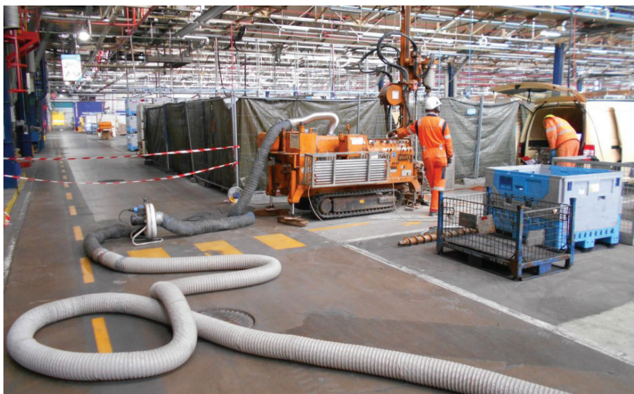
Figure 1 : Sondage MIP à l'intérieur d'un bâtiment.
