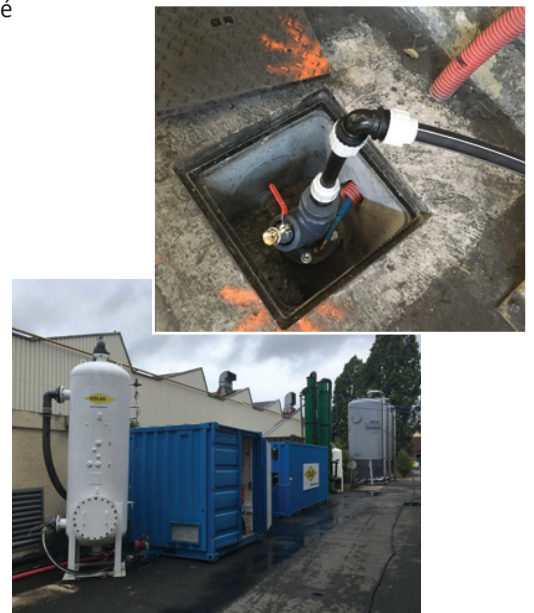
Figure 3 : Système d'extraction multi-phases et unités de traitement.
