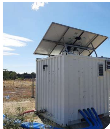
Process de dépollution in-situ à énergie solaire
