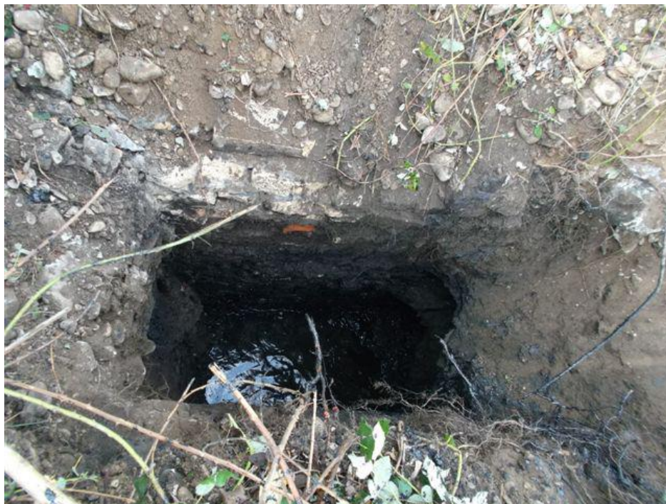
Figure 5 - Constat de présence de phase organique flottante lors d'une fouille ayant atteint la nappe
